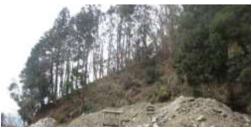
山腹崩壊の危険が指摘された斜面
