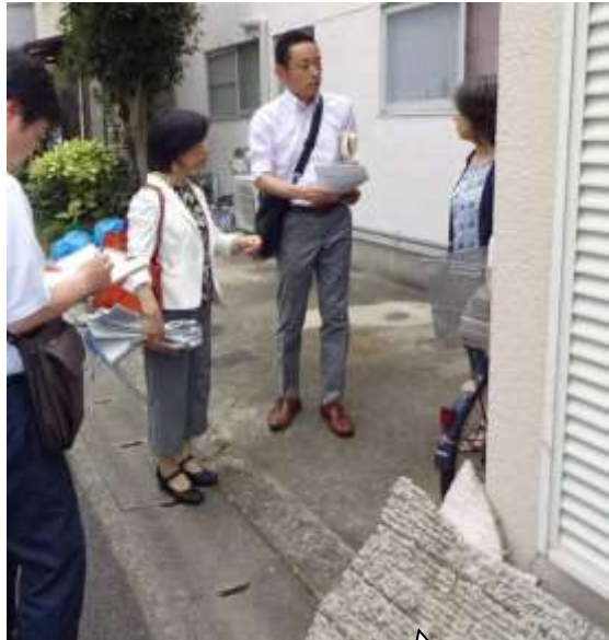
被災者から聞き取り 写真右下は崩落した外壁
