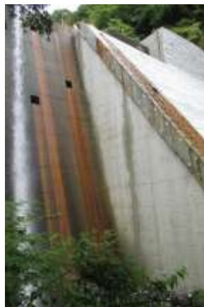
右側が補修工事の終わった部分
